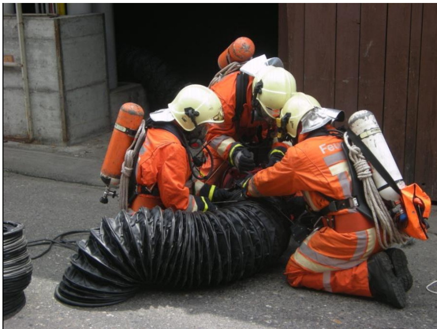
Feuerwehrleute beim installieren des Lüfters
